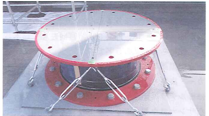
↑「積層ゴム支承」(写真1)
