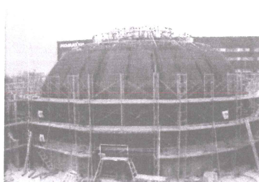
トラスウォール据付状況
