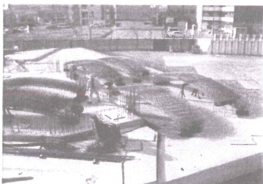
トラスウォール搬入状況
