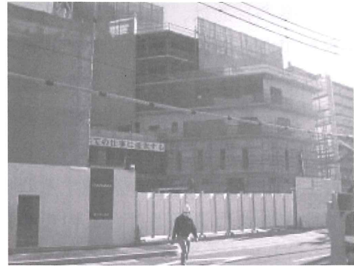
【現地工事現場の様子】
